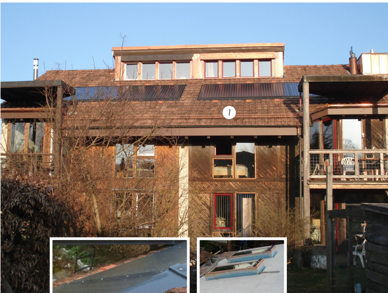
1 Innenliegende Solarkollektoren 2 Hinterlüftung der Kollektoren 3 Neue, dreifach verglaste Dachfenster
