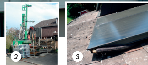
1 Die grossen Fensterflächen benötigen eine gute Wärmedämmung. 2 Der Bohrer für die Erdwärmesonde. 3 Solarkollektoren für die Warmwasseraufbereitung.
