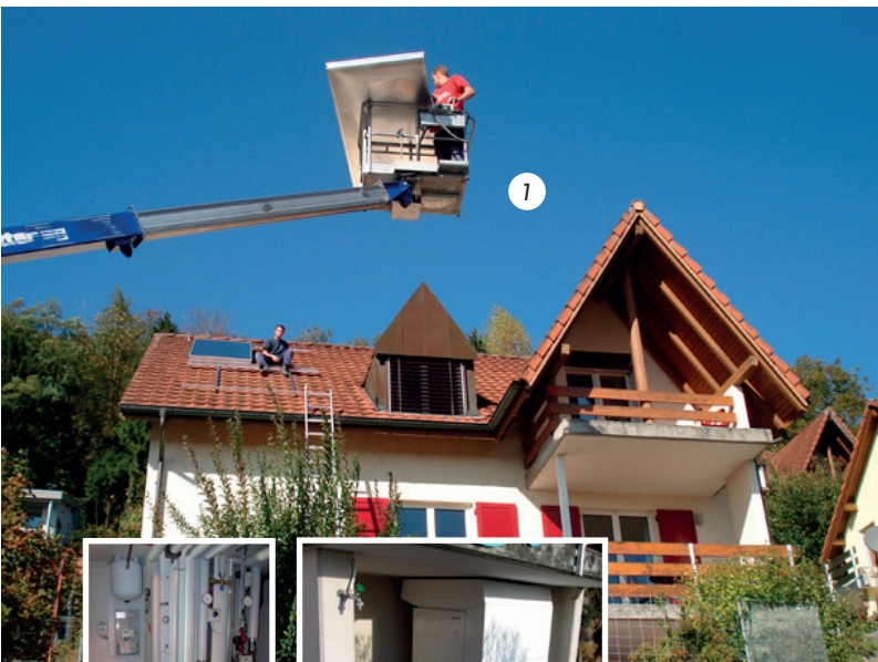
1 Montage der Solarpanels. 2 Speicher für Wärmepumpe und Solarkollektor im Keller. 3 Die Luft-Wasser-Wärmepumpe unterhalb des Sitzplatzes.
